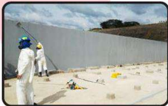
Recubrimiento anticorrosivo y reforzamiento con fibra de carbono Anticorrosive coating and carbon fiber reinforcement PEMEX, Comalcalco, Tabasco.
